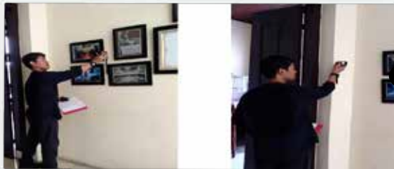
MENGUKUR DENGAN DISTOMETER (LASER METER)
