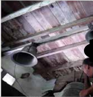
SURVEY AWAL RUANG IBADAH DAN MENARA LONCENG
